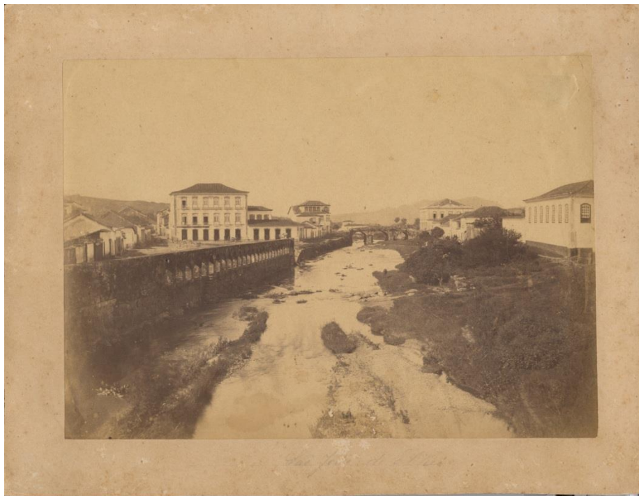
Figura 9 – Chafariz dos Arcos, s.d.
