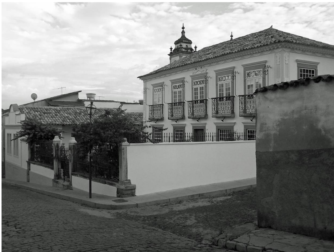
Figura 4 – Edifício do século XVIII, reformado na metade do século XIX a fim de se adaptar às novas exigências estéticas da arquitetura da cidade.
